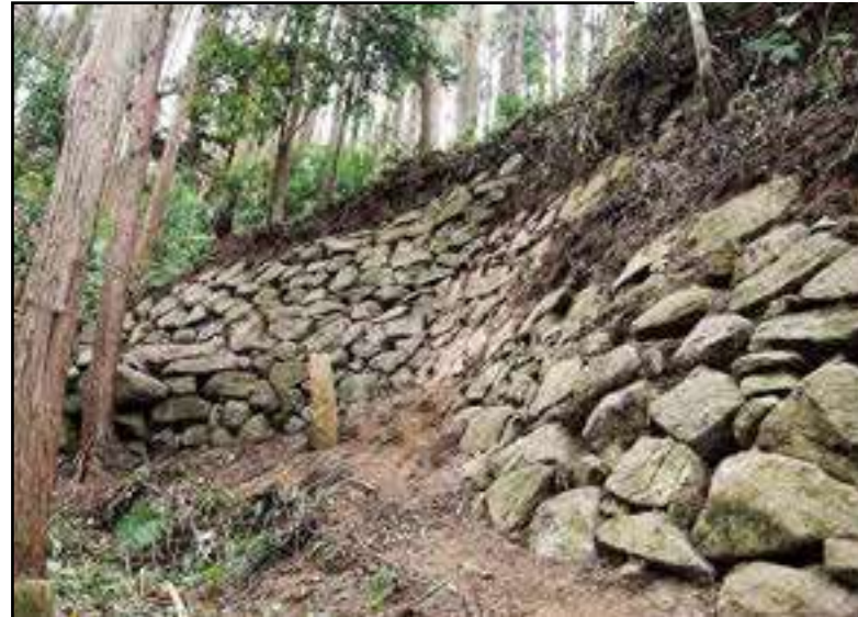
曲輪を取り巻く石垣
